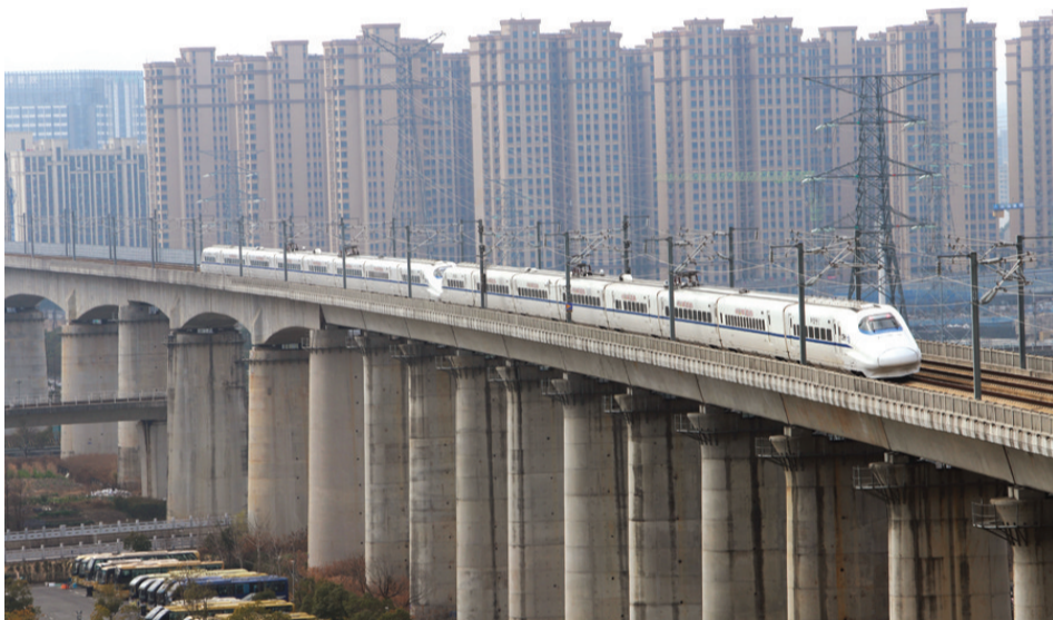
2月1日,一辆动车组列车行驶在杭台高铁灵山泾特大桥上。
