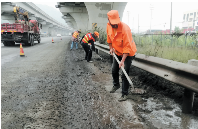
随着梅雨季节到来,雨水天气增多,目前,区公路管理局加强公路巡查力度,重点检查路面积水、路堤边坡水毁冲沟、边沟淤塞等情况,发现问题立即处理,及时修补路面坑洞,确保辖区道路安全畅通。
