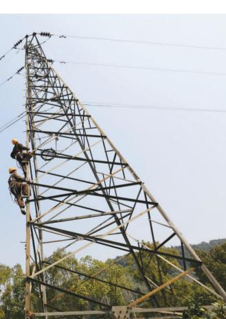
近日，供电公司高空作业人员在35千伏枫升线上安装避雷线，为即将到来的雷雨季节安全防雷做好准备。
