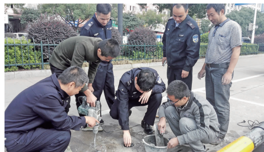
11月9日,在路桥大道永安广场路段,施工人员正和路北中队的城管执法人员一起安装智能停车收费系统地面磁感应器。今年下半年,我区开始第二期智能停车收费系统700多个停车位的建设,预计到明年初,路桥大道等6条路段将全部实行差异化收费,这标志着智能停车收费系统从城区核心区向次核心区扩展。本报记者 陈政羽 摄
