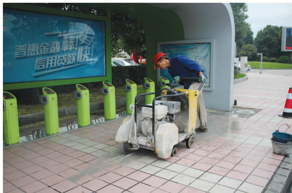
日前，市政处组织工作人员检查路桥大道路面情况。路桥大道是主城区重要的交通道路，因日常车流量较大，造成路面破损、翘起，坑洼不平，严重影响市民出行。10月15日起，市政处开始对路桥大道进行修补改造。图为工人正在对电力大厦前自行车租赁点的路面进行切割。
