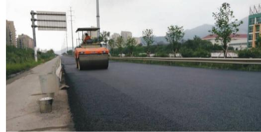
先将路面铣刨，紧接着，第二辆车将施工前洒在路面的沥青油、水泥、石子进行搅拌，第三辆车则将路面压实即可。沥青路面冷再生技术在我区公路养护中已持续运用多年，且就目前情况来看，该项技术比较成熟。今年，该技术再次应用于院路线路面修复工程，大大提升了施工效率，为市民的交通出行提供了便利。
