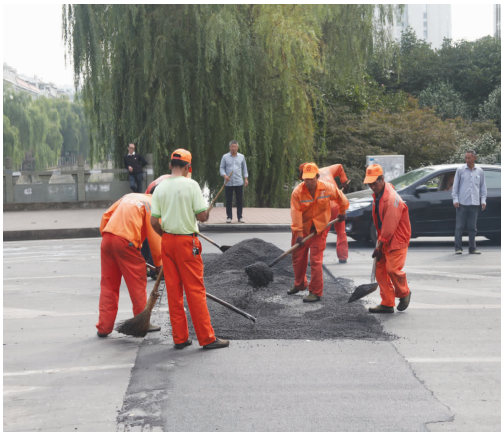
近日,市政维修人员正对商海南街人民桥的桥面接缝破损处进行修整,还桥面一个平整的路况。据了解,随着车流量的不断增多,不少桥面接缝出现了破损,市政处正在加紧进行修补,确保市民、车辆正常通行。
