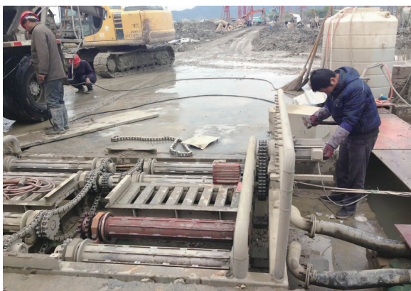
某一工地清洗机正在维护,执法人员要求工地的混泥土车推迟进场。通讯员 许校溢 摄
