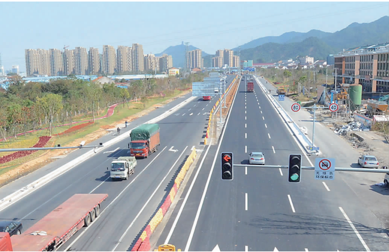
日前,路院一级公路拓宽改造工程(财富大道西侧路桥段)主体道路已拓宽通车,为畅通路桥打下了坚实基础,也是路桥大交通建设中的又一亮点。 本报记者 王挺 摄
