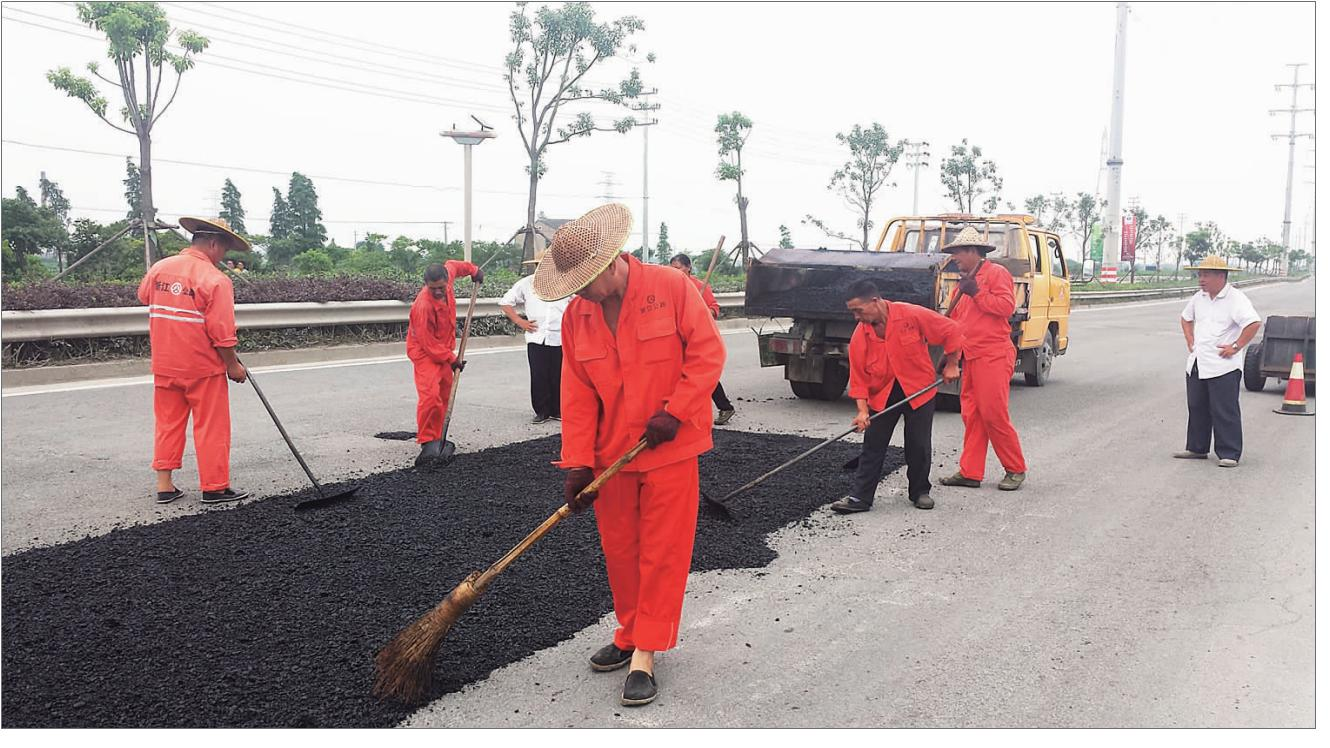
7月16日，公路部门组织人员对东方大道路段的沥青路面坑洞进行修补。据了解，持续降雨导致沥青路面出现松散、坑洞等“病害”现象，一定程度上影响了公路的安全畅通。为消除隐患，公路部门抓住晴好天气，及时安排公路养护人员对破损沥青路面坑洞进行技术修补，尽快恢复路面通畅，提高公路的安全通行能力。
