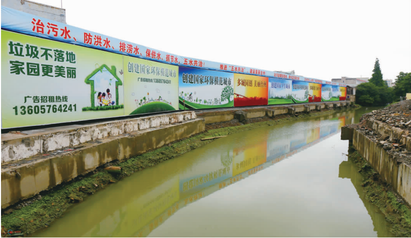
今年3月末,路桥街道全面拆除了洋张泾良一段的违建“河上市场”,使得数百米的河道“重见天日”。经过几个月的整治,该河道除了重新畅快呼吸外,还由臭水沟变成了一泓碧泉,成了我区“五水共治”的典型宣传点。 本报记者 陈璐 通讯员 林继德 摄
