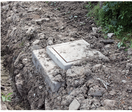
连通化粪池的小方井
