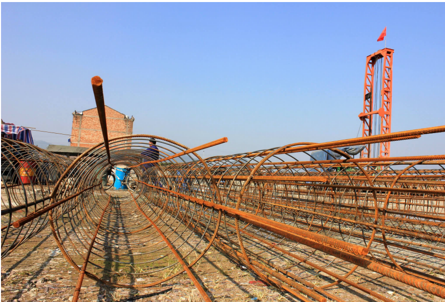
路桥生活资料市场园区(一期)商城区块建设项目,位于西市场园区东北角,项目总规划用地面积为 228.61 亩。经过多方紧锣密鼓的努力,目前,该项目已经完成所有现场勘探工作以及主楼部分的试桩工程施工。今年年底开工建设,预计全部工程于 2015 年底完工。
